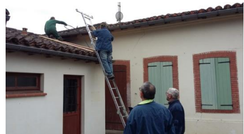
Mise en place du câble Bernard, Jean-Luc, Daniel et Pascal
