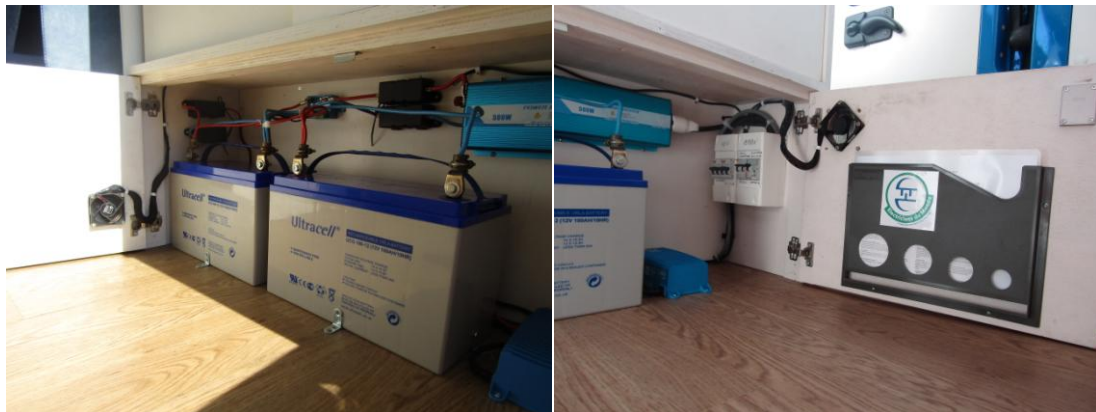
L'installation terminée et prête pour une aide aux gens de la rue
