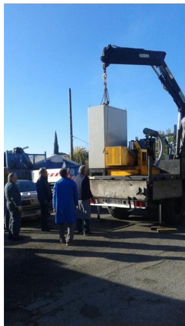
Le déchargement du groupe et de son armoire de commande à Ballufet
