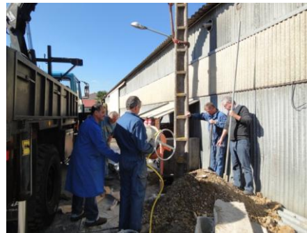
1 camion- grue et 1 poteau
