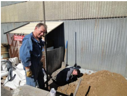
2 terrassiers costauds pour un trou d'au moins 1,7m de profondeur
