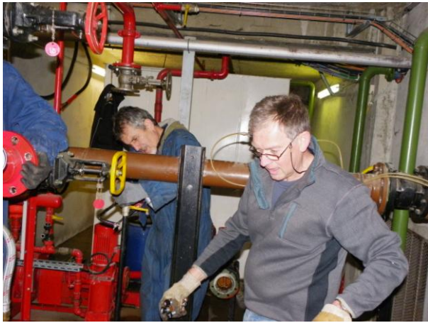
La dépose de tuyauterie
