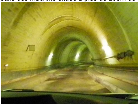
La galerie d'accès
