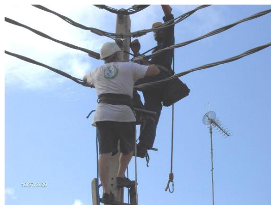
Christian câble le réseau Moyenne Tension du transformateur. Maurice surveille les travaux en hauteur.
