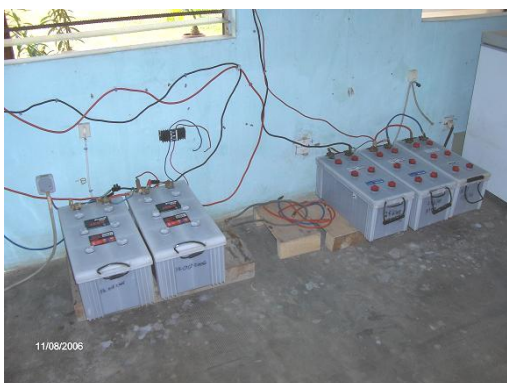
L'électricité photovoltaïque n'est pas bien traitée. De même que le groupe électrogène entretenu par un soi disant technicien béninois. Voir le câblage arraché.
