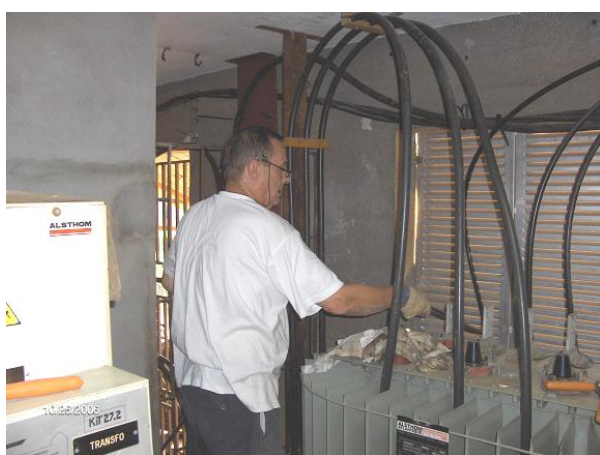
Christian câble le réseau Moyenne Tension du transformateur. Maurice surveille les travaux en hauteur.
